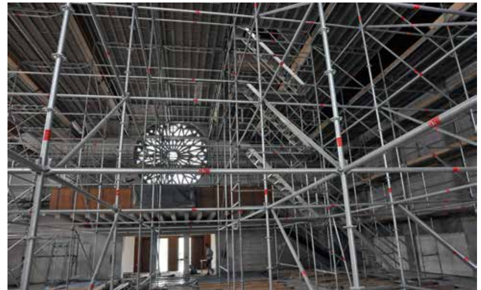
Der für die Renovierung vollständig eingerüstete Kircheninnenraum
